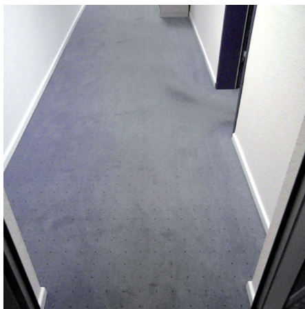
Bild 1: Ausgangszustand: schmutzige Laufstraße
